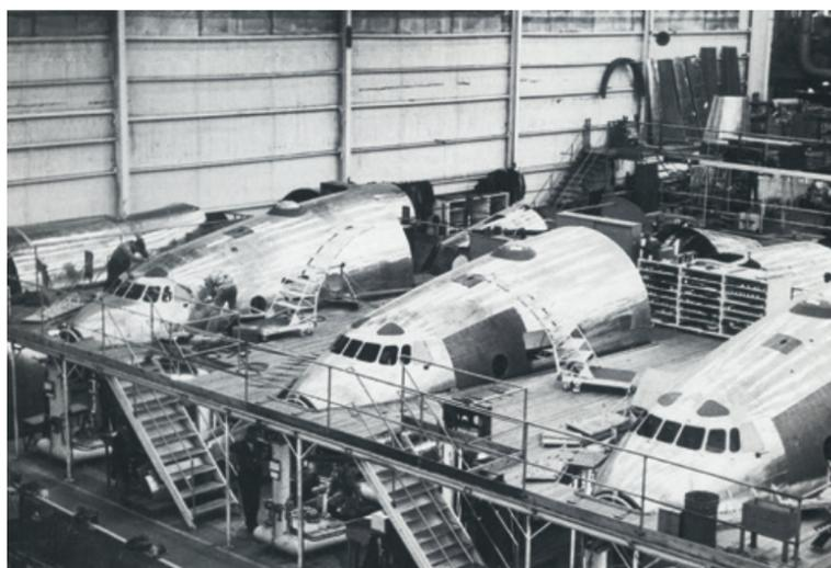
A montagem das fuselagens era feita numa seção separada da fábrica e elas eram depois unidas às asas em outra linha de fabricação
